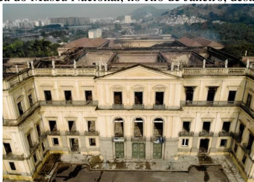
Figura 1. Vista aérea do Museu Nacional, no Rio de Janeiro, destruído após incêndio.
