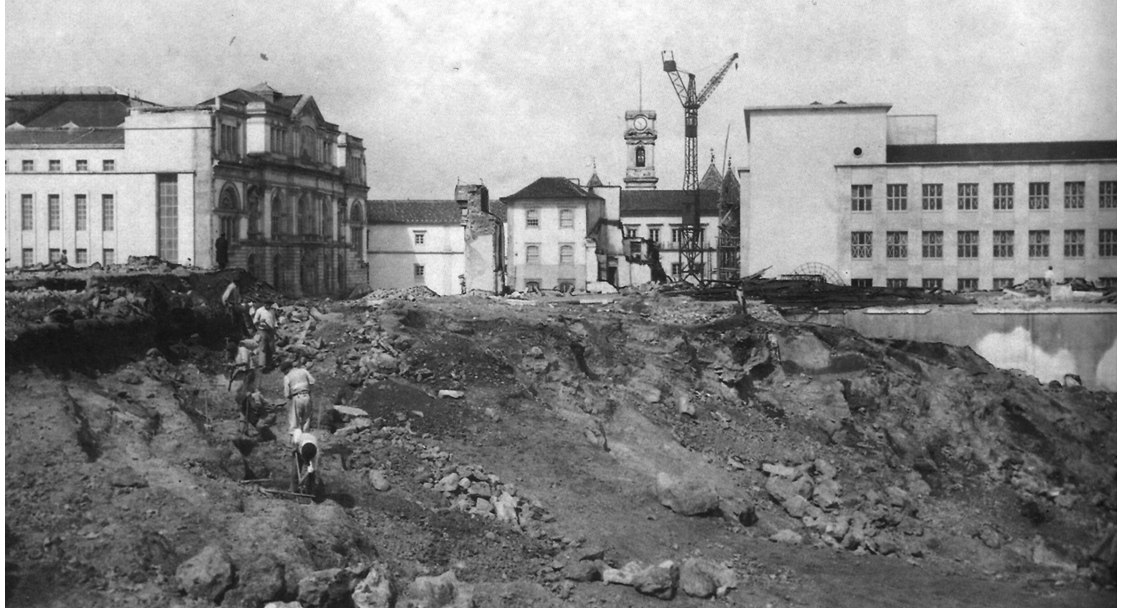
Figura 2. Demolições durante a construção da Cidade Universitária de Coimbra. 1943/1944. Fonte: A Velha Alta... Desaparecida: Álbum comemorativo das bodas de prata da Associação dos Antigos Estudantes de Coimbra (Coimbra: Almedina, 1984), 50.
