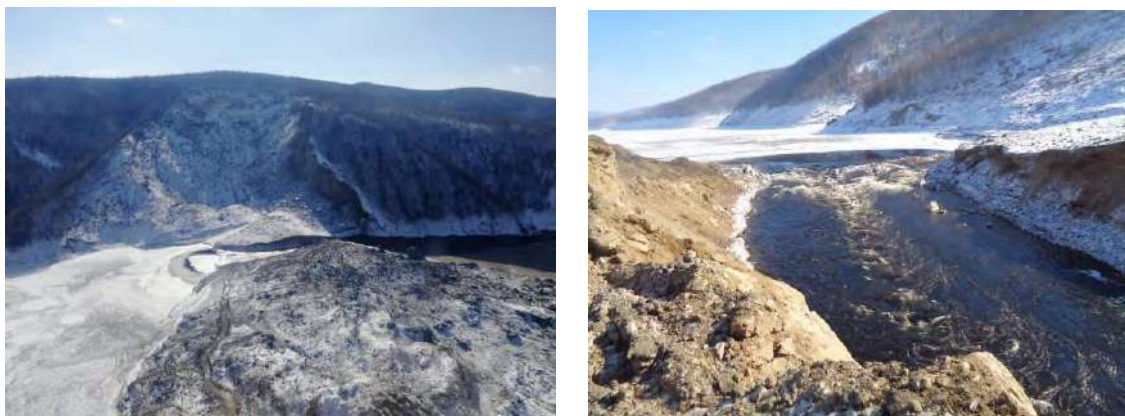
Рис. 2. Стенка срыва и оползневое тело (слева) и проран для пропуска вод из верхней части водохранилища в нижнюю его часть (справа)
