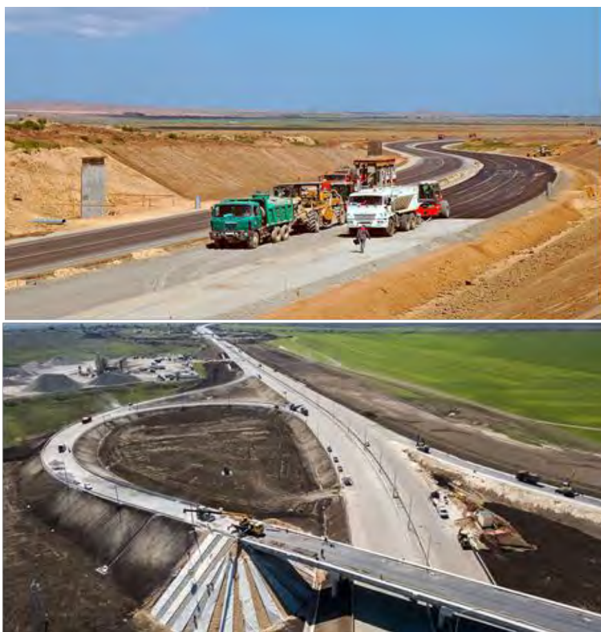
Рис. 2. Фрагменты строительных работ трассы Таврида
