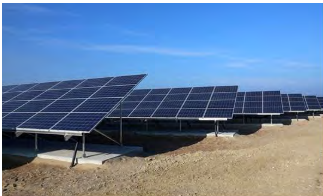
Рис. 4. Фотоэлектрическая станция пиковой электрической мощностью 1000 кВт в г. Каспийске, Республика Дагестан, 2013 г.
