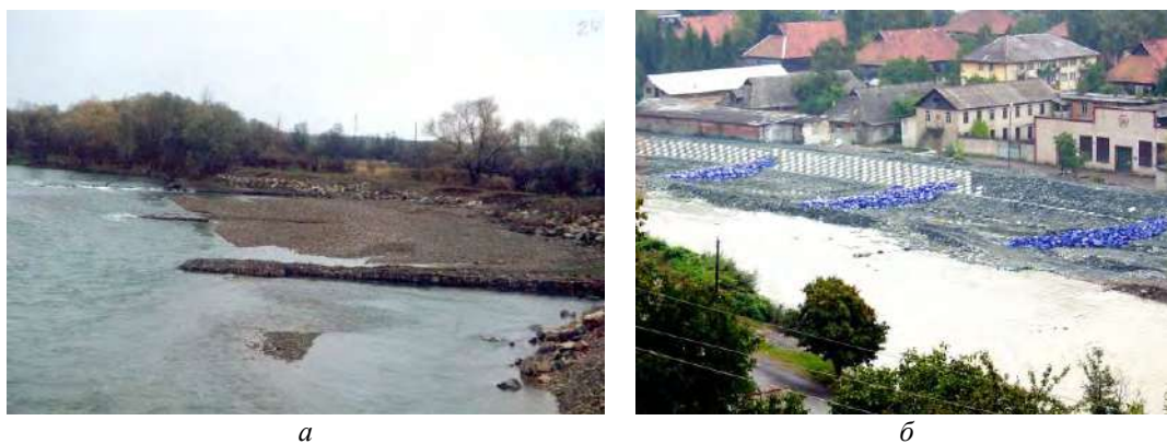
Рис. 2. Расположение косорасположенных (а) и нормальных (б) потоку полузапруд для защиты берегов горных рек.
