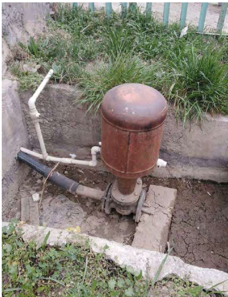
Рис. 1. Гидроударный насос.
