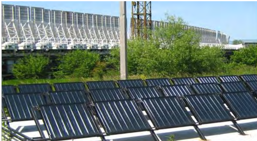
Рис. 3. Солнечная станция круглогодичного теплоснабжения радиотелескопа РАТАН-600, Специальная астрофизическая обсерватории РАН, Карачаево-Черкесия
