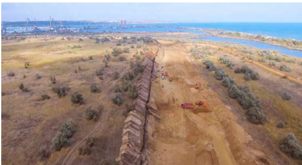
Рис. 2. Современное состояние песчаных защитных барьеров
