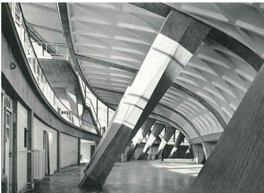
Figure 8. Palazzo dello Sport raking columns [1]
