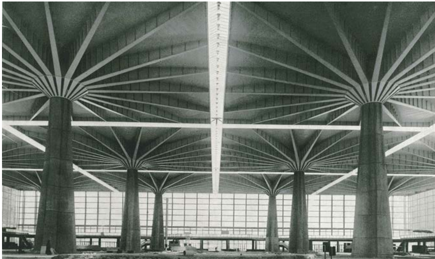
Figure 7. Palazzo del Lavoro stem columns [1]
