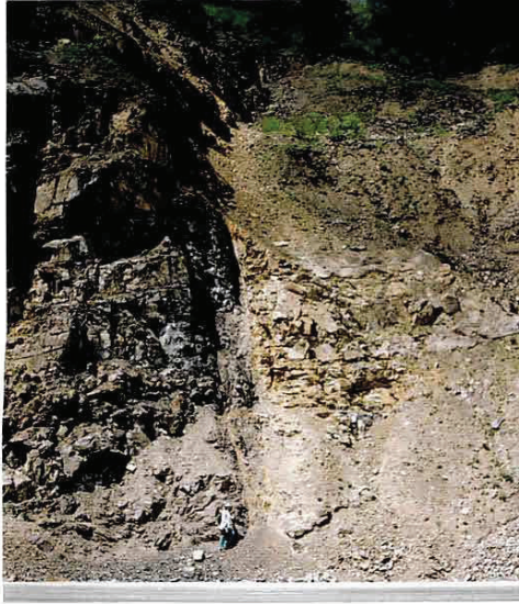
Şekil 21. Bekçiler mezrası civarında Çatak Formasyonunda gözlenen F_1 fayı ve Nara Burnunda, Çatak Formasyonunda yer alan F_2 fayı
