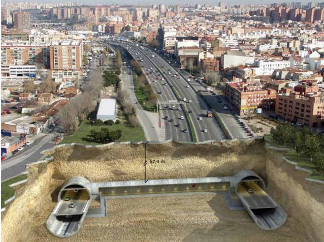
Figura 21. Soterramiento del tráfico en la M-30.
