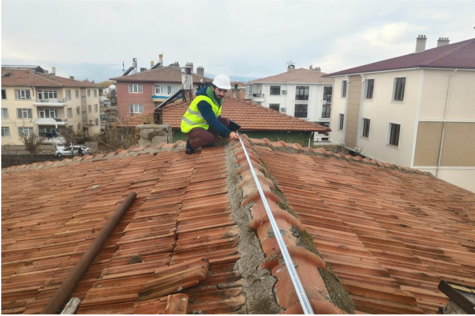
Şekil 6. Örnek bir bina çatısında yapılan ölçümlerden bir görüntü
