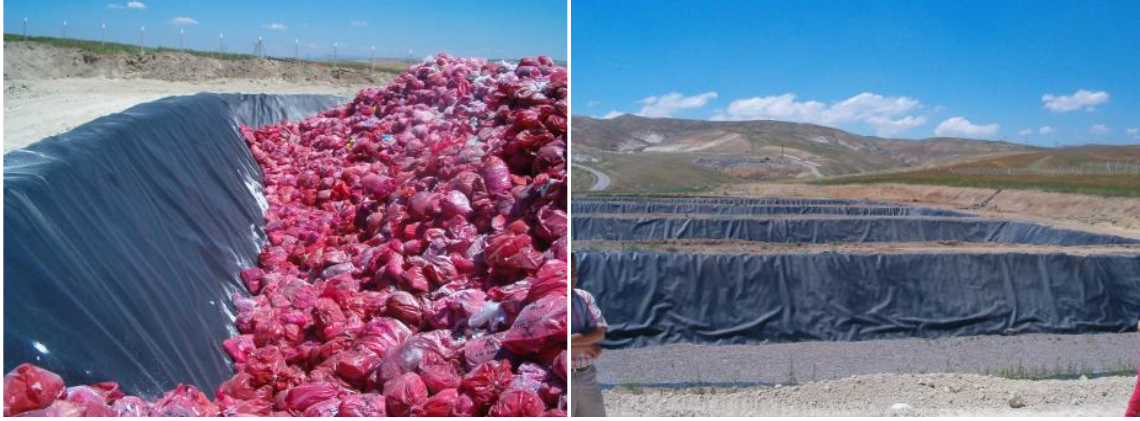
Şekil 5. Tıbbi Atıkların Düzenli Depolanması
