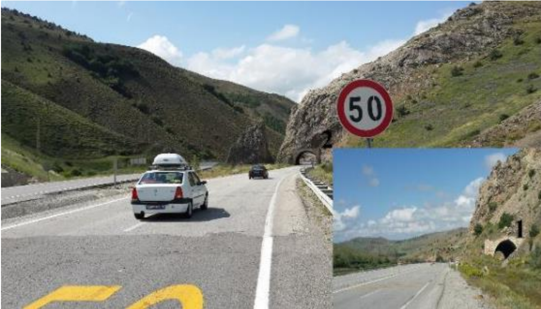
Fotoğraf 9. Heyelan nedeniyle kapanarak yol güzergâhının değişmesine neden olan (1) ve yeni yol güzergâhında hâlihazırda kullanılan (2) karayolu tünellerinden görünümler.
