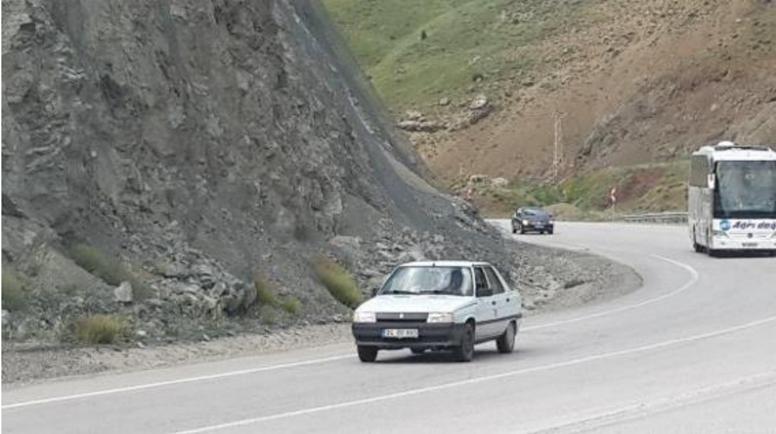
Fotoğraf 2. Yamaçlardaki akmalara ve özellikle ayrılmış kaya parçalarına karşı önlem olarak yapılan çelik kafes uygulamalarına bir örnek.
