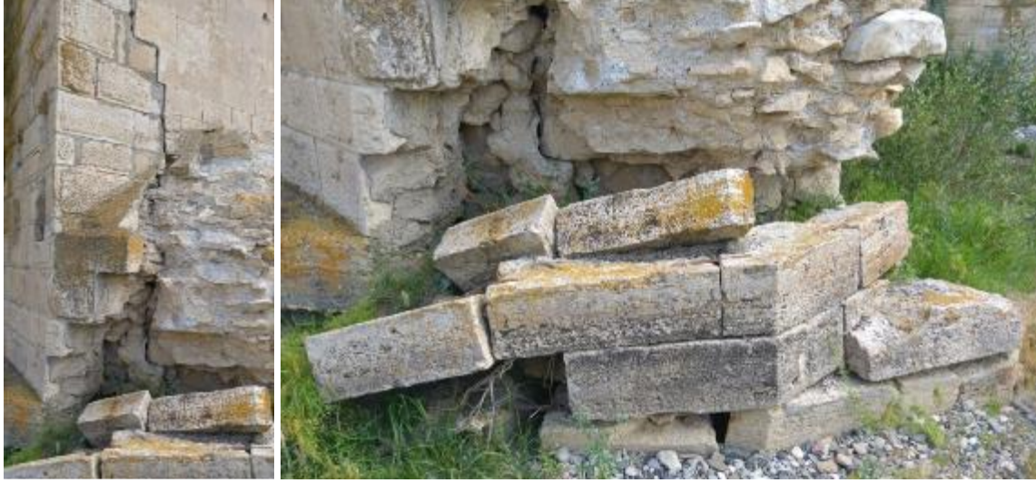
Şekil 10. (a) Restorasyonda uygun olmayan malzeme kullanımı (b) Taşlarda tuzlanma (Fotoğraf: M. Sağır)
