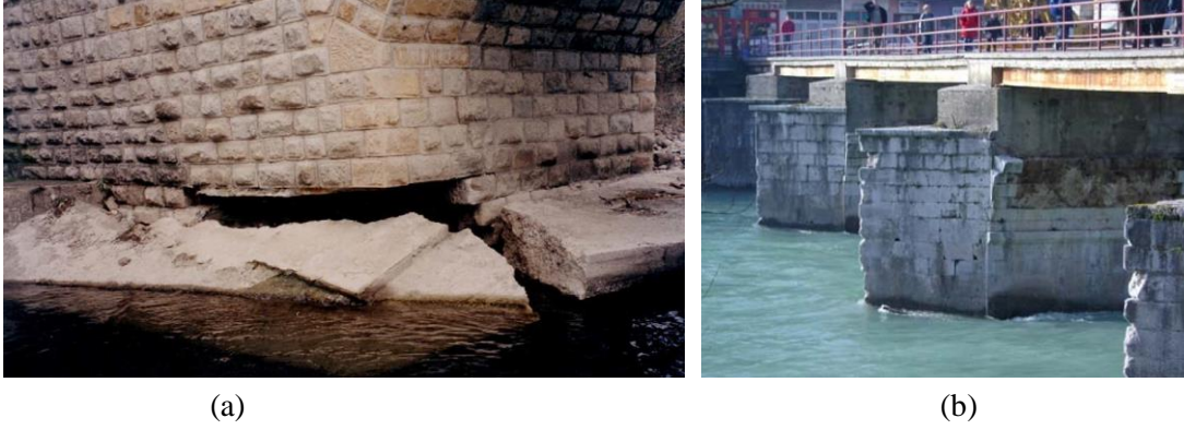
Şekil 2. (a) Mataracı Köprüsü kemer ayağında sel hasarı[3,5], (b) Konjic Köprüsünde selyaran hasarları[7]
