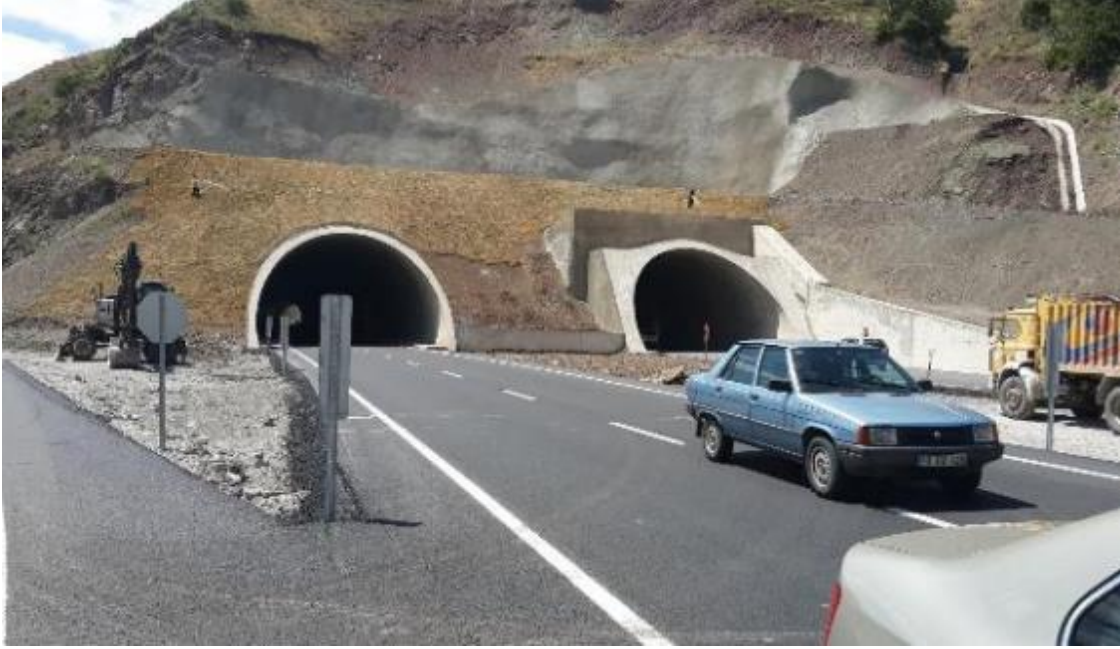
Fotoğraf 8. Erzincan-Tunceli sınırında yer alan tüp tünellerden bir görünüm.
