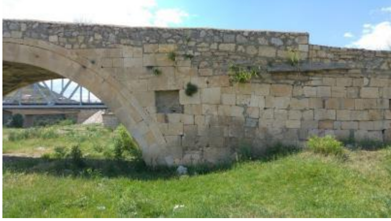
Şekil 9. Kütle bozukluğu ve bitkilenme (Fotoğraf: M. Sağır)
