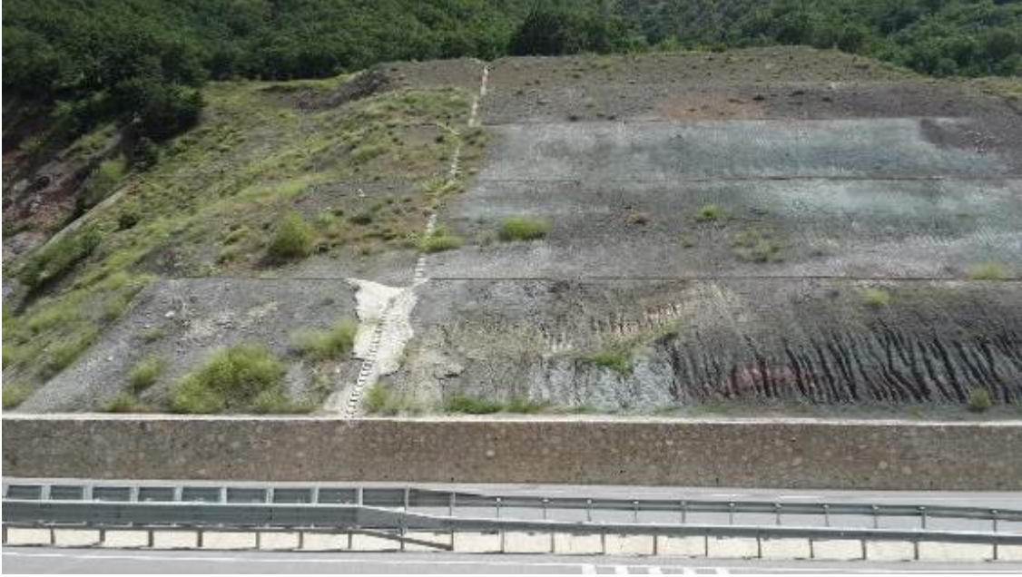
Fotoğraf 3. Kütle hareketlerine karşı istinat duvarı ve taraçalama yapılarak düzenlenmiş bir yamaç.
