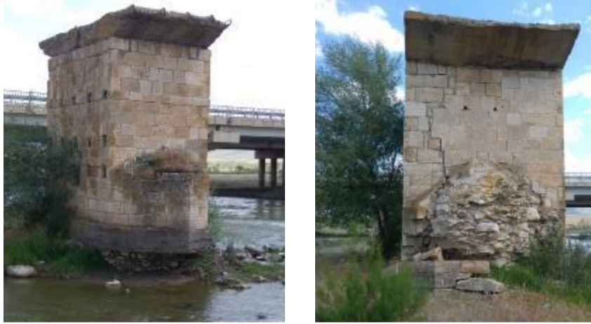
Şekil 12. (a) Ayaklarda oyulma (b) Selyaran hasarları (Fotoğraf:M.Sağır)
