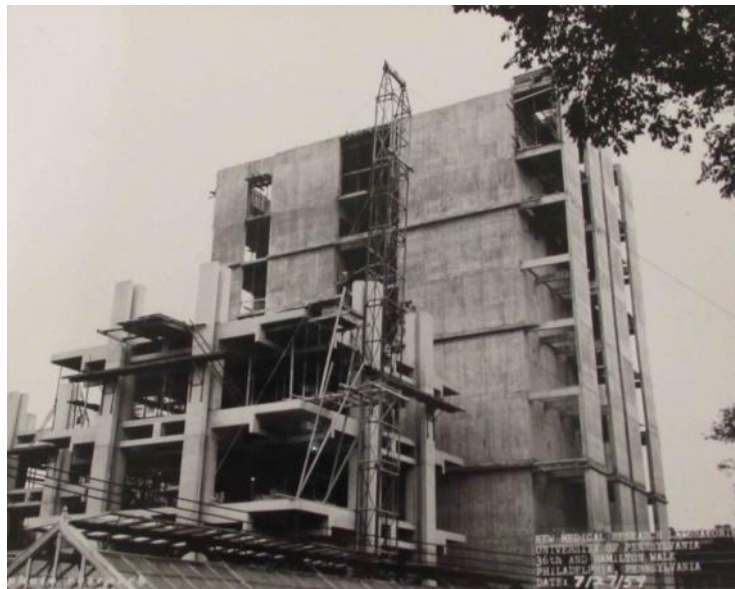
Fig. 10 Fotografía que muestra los dos sistemas constructivos, las piezas prefabricadas y el hormigón in situ de la torre "X". No. de archivo: 030. IV.A.490.12.51.The A.A., U. of Penn.
