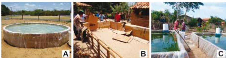
Figura 12. Tanques construídos com material reciclado: madeira e papelão (A) e taipa revestida com plástico (B e C).
