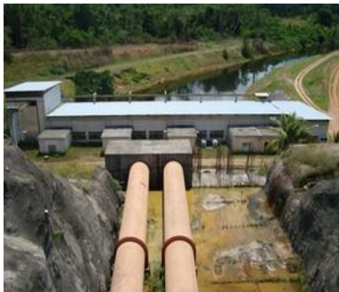
Foto 1: Usina Hidrelétrica de Jatapu com 2 turbinas em 2013 (Foto Divulgação/CERR).
