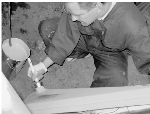
ФОТО. Окраска рабочим, конструкции по ржавчине и старой краске
