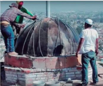
**Figura 14:** Armado de la cúpula
