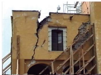
**Figura 5:** Desplome en 2o.Piso muro norte
