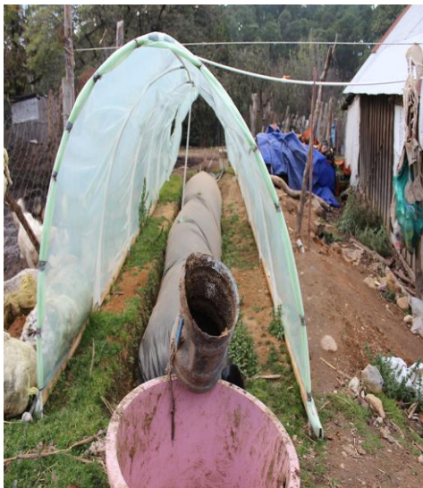
Figura 4. Biodigestor y estufa usando gas producido en este, Los Pescados, municipio de Perote, Ver.
