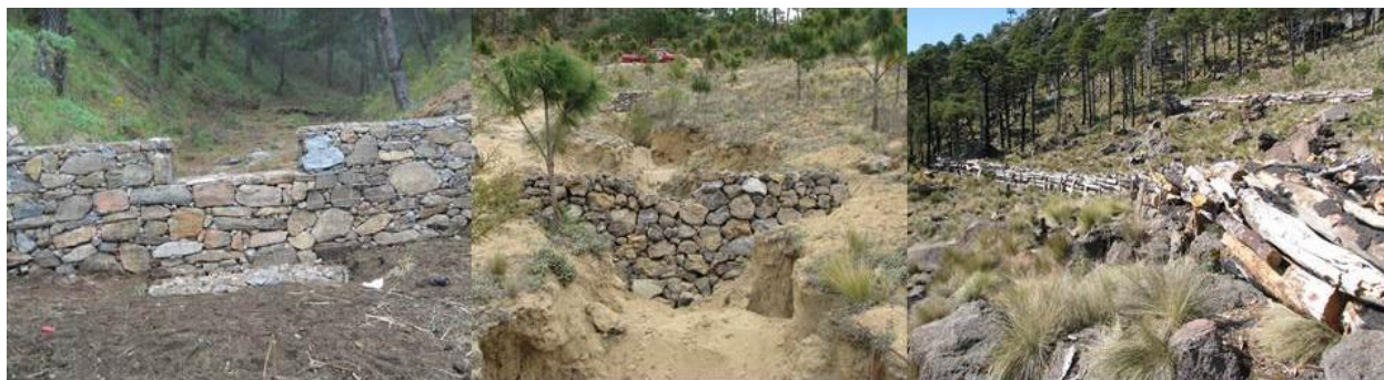
Fig. 4 Presa de gavión, Presa de piedra acomodada y Acordonamiento de material vegetal.
