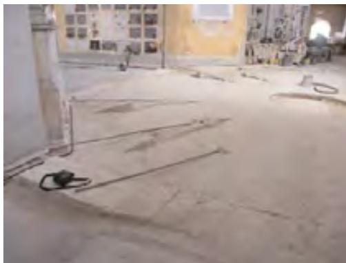
già effettuato gran parte del suo cedimento fondale, risultando leggermente rototraslata a causa del proprio cedimento edometrico, in presenza di una falda ancora superficiale;
