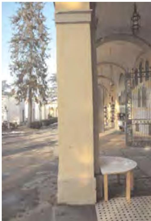
Fig. 9 - Fotografia del pilastro dell'arco 1 in cui si evidenzia il fuori-piombo del colonnato (fino a 6 cm).
