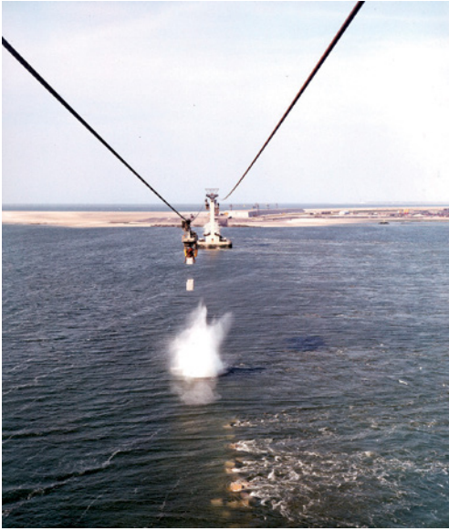
Figuur 2. Sluiting van de Brouwersdam. Foto Rijks-waterstaat. Figure 2. Closing of the Brouwersdam. Photo Rijks-waterstaat.
