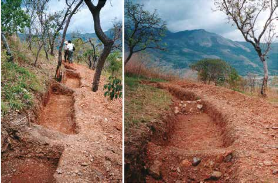
Figura 47. Zanjas de infiltración.
