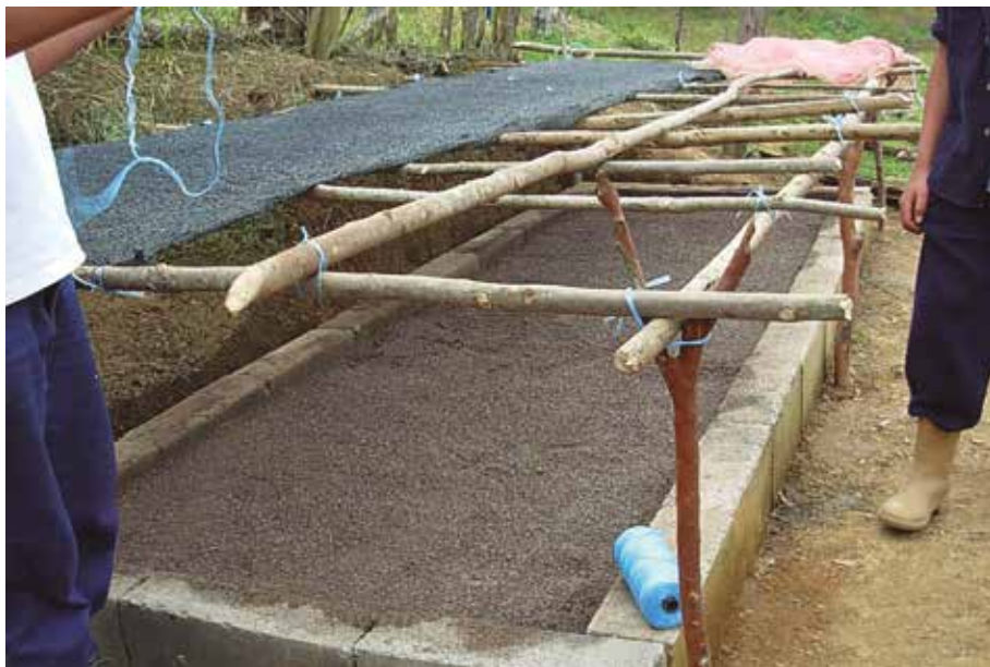
Figura 7. Construcción de germinador con bloque.
