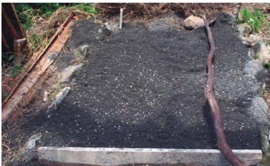
Figura 8. Construcción de germinador temporal con borde de piedra.
