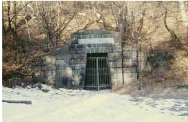
Fig. 3: Entrance of the mine Jozef in Libanka. Foto: Š. Danko.
