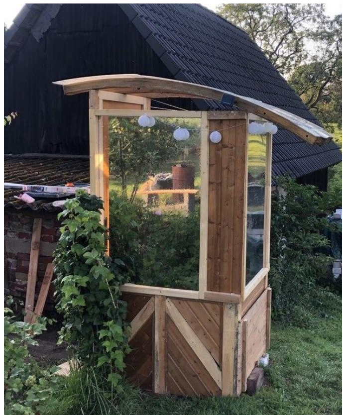
Abbildung 3: Klo_Spionspiegel: Von Aussen verspiegelt, doch von Innen hat Frau den Durchblick. Im Spionspiegelklo gibts gute Aussicht mit 270° Rundumblick
