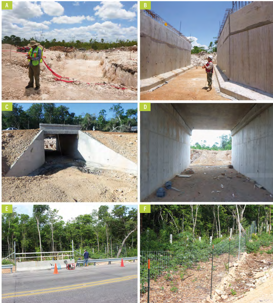
Figura 4. Imágenes del seguimiento de la construcción de los PSF en la carretera Nuevo Xcan-Playa del Carmen, en el estado de Quintana Roo, México. (Fotografía: SEGA.) A) Evaluación de la ubicación de los PSF, así como de aspectos del hábitat circundante al PSF. B y C) Supervisión de la construcción de los PSF para determinar las necesidades de adecuaciones específicas para mejorar su funcionalidad. (Fotografías: SEGA.) D) Evaluación de las adecuaciones en rampas de acceso a los PSF para facilitar el cruce seguro de fauna silvestre a través de ellos. (Fotografía: SEGA.) E) Supervisión de la instalación de mallas de inducción que dirigen a la fauna silvestre hacia la entrada de los PSF. (Fotografía: Alejandro Jesús de la Cruz.) F) Finalización de la instalación de la malla de inducción. (Fotografía: Alejandro Jesús de la Cruz.)
