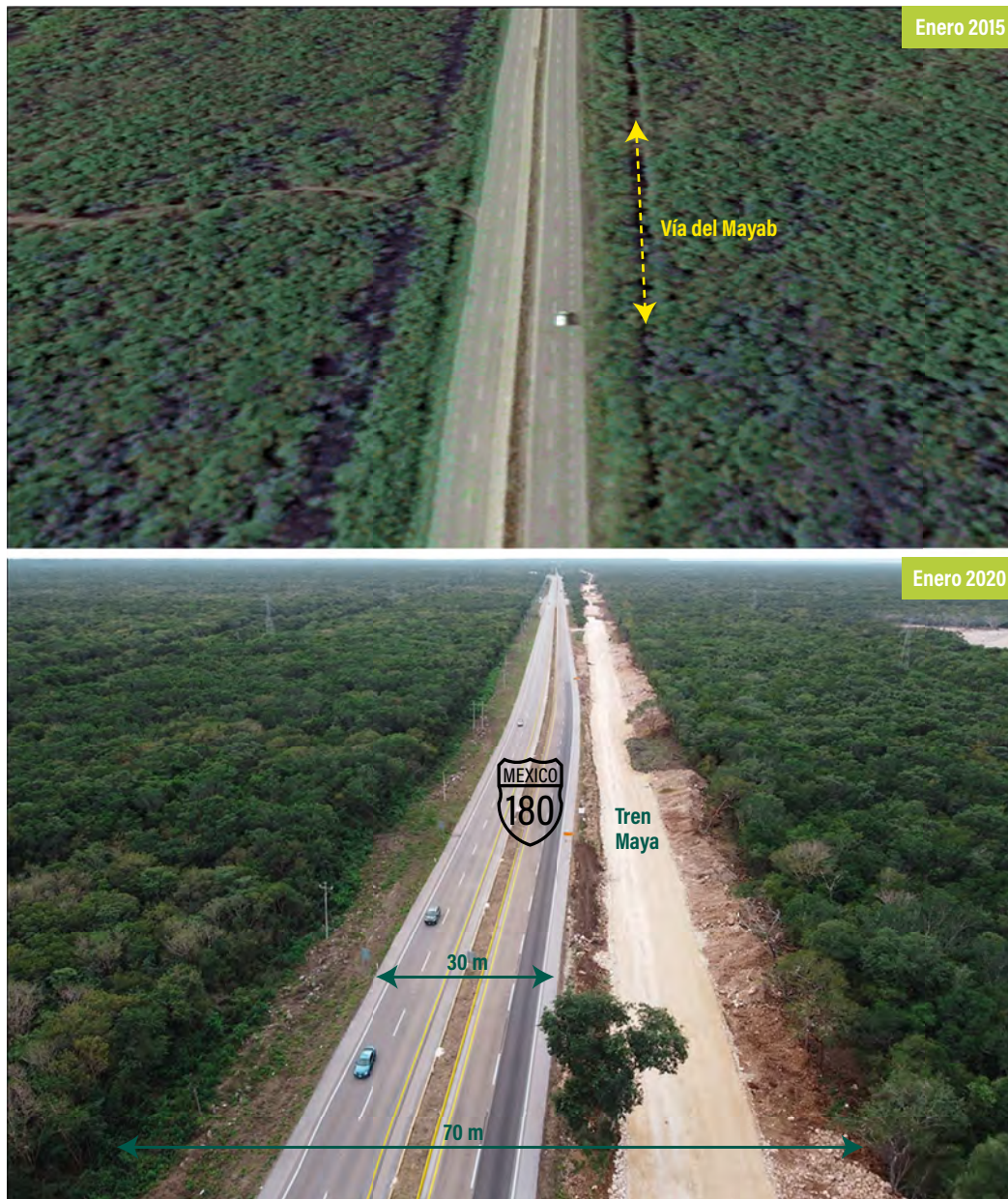
Figura 3. Eliminación directa de hábitat para la construcción del Tren Maya, el cual está paralelo a la carretera 180, tramo Campeche-Mérida, entre Kopomá y Maxcanú. [Elaboración propia a partir de imágenes del mismo sitio tomadas de Google Earth (2015) y mediante dron (2020), por Jorge A. Benítez.]
