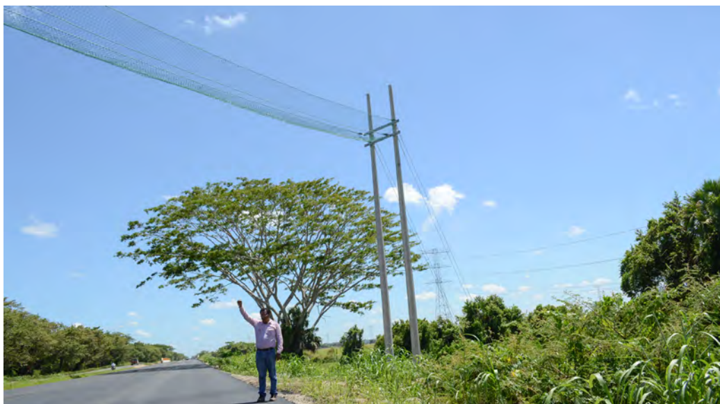
Figura 13. Paso superior para fauna arbórea colocado en la carretera 186, tramo Villahermosa-Escárcega, en un sitio desprovisto de vegetación arbórea y sin presencia de monos aulladores. (Fotografía: Gilberto Pozo-Montuy.)
