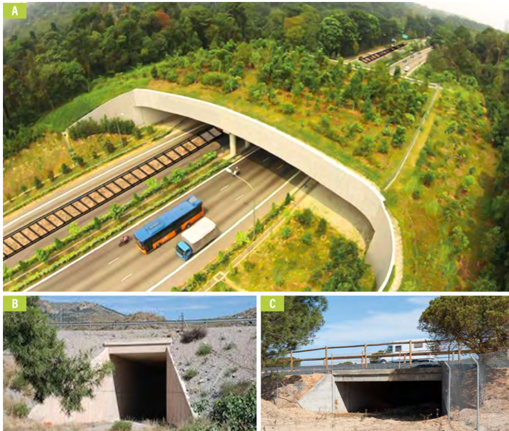
Figura 8. Fotografía A: ejemplo de paso superior de fauna ( wildlife overcrossing/overpass ) sobre una carretera y vía férrea, también llamados pasos inferiores vehiculares (P. I. V.). (Imagen tomada de https://www.nparks.gov.sg , con modificaciones.) Fotografías B y C: ejemplos de pasos inferiores de fauna ( wildlife underpass ), también llamados pasos superiores vehiculares (P. S. V.). (Imágenes tomadas de http://www.aopandalucia.es )
