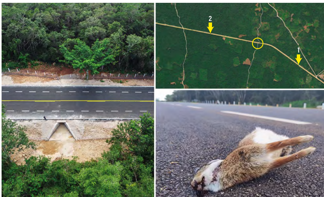
Figura 14. La imagen izquierda muestra un paso de fauna inferior (PFI; número 2 de la imagen derecha). La imagen de Google Earth muestra las veredas que atraviesan la carretera, así como la ubicación de dos PFI (separación de 1.5 km), y el sitio de atropellamiento (círculo) de la liebre de la fotografía inferior. (Imágenes tomadas por Jorge A. Benítez, durante los trabajos de ampliación y modernización de la carretera Mérida-Chetumal.)
