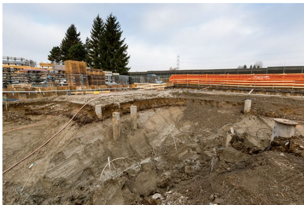
Abb. 29 Steinhausen, Sumpfstrasse 18. Nordwestecke der Baugrube. Unter Auelehmpaket und frühbronzezeitlichem Verlandungstorf sind die massiven, schräg gegen Südwesten einfallenden Deltasedimente aufgeschlossen. Blick gegen Nordwesten, hinter dem orangen Absperrzaun führt die Autobahn nördlich am Bauperimeter vorbei.
