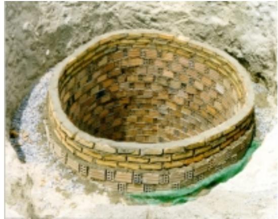
Figura 4 - Poço amazonas construído com tijolos furados na porção inferior e tijolos maciços na parte superior.
