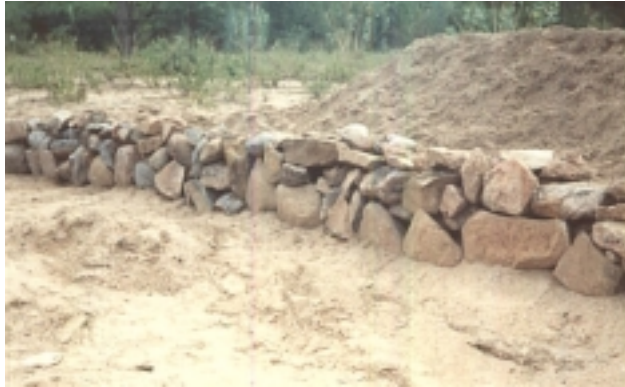
Figura 3 - Enrocamento de pedras na barragem SJ (Mutuca-PE).
