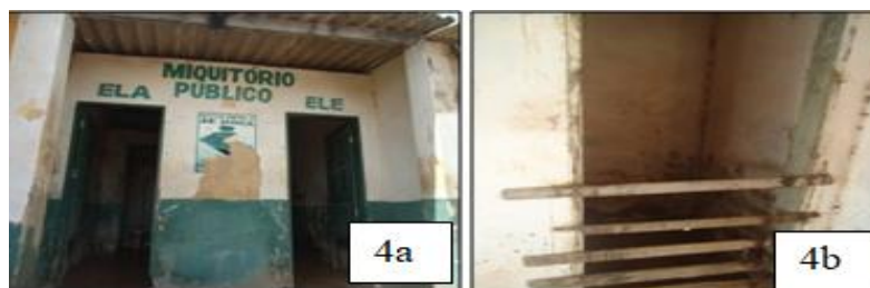
Figura 4 - Instalações sanitárias nos mercados A e B (4a e 4b).
