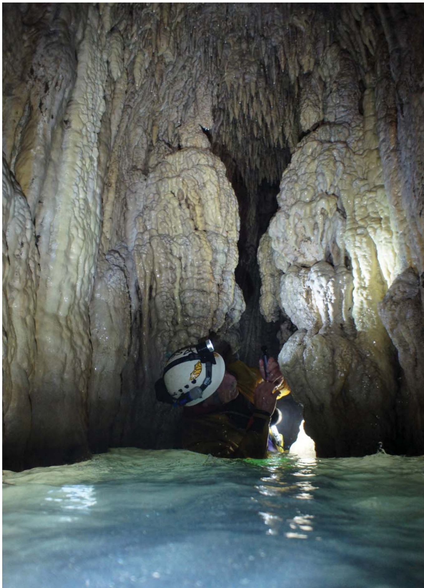
Fig.8: the impressive speleothems that create an obstacle to the water flow in the Albano drainage tunnel (photo S. Barbaresi). Fig. 8: le imponenti concrezioni che ostacolano il flusso dell'acqua nell'emissario albano (foto S. Barbaresi).
