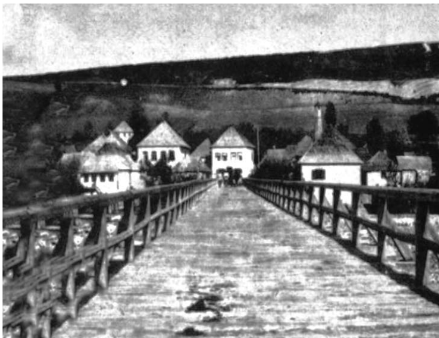
Slika 169. Drveni most u Beranama, porušen 50-tih godina prošloga vijeka
