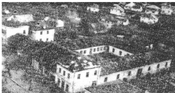
Slika 200. Zgrada nekadašnje Sadri-esbek Osman-paša medrese
