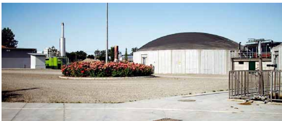
Digestore primario e cogeneratore nell'azienda agricola Colombaro Due
