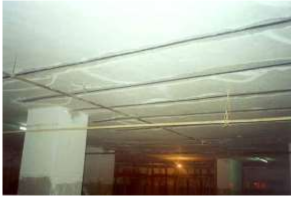
تدعيم السقف في منطقة عزوم الإنحناء الموجبة
