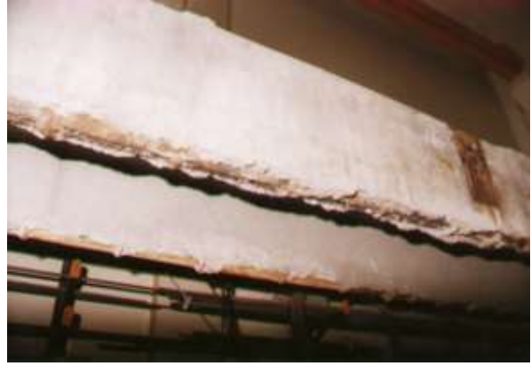
الحالة الراهنة للكمرات: صدأ حديد التسليح - أنهيار الغطاء الخرساني لحديد التسليح - شروخ متنوعة
