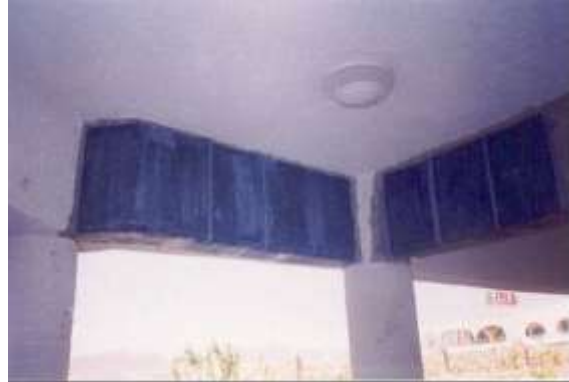
تدعيم الكمرات برقائق المواد البوليمرية المسلحة بألياف الكربون لزيادة مقاومتها لعزوم الإلتواء
