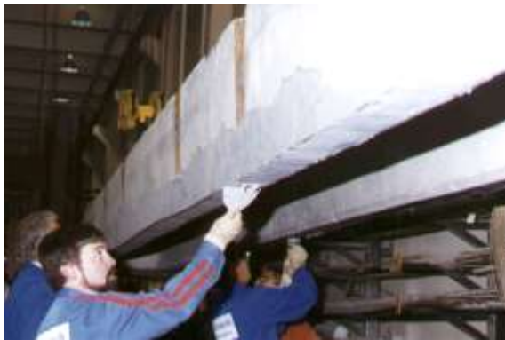
شكل رقم ٦ . خطوات تثبيت ألواح المواد البوليمرية المسلحة بألياف الكربون على الخرسانة
