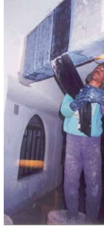
تدعيم الكمرات برقائق المواد البوليمرية المسلحة بألياف الكربون
