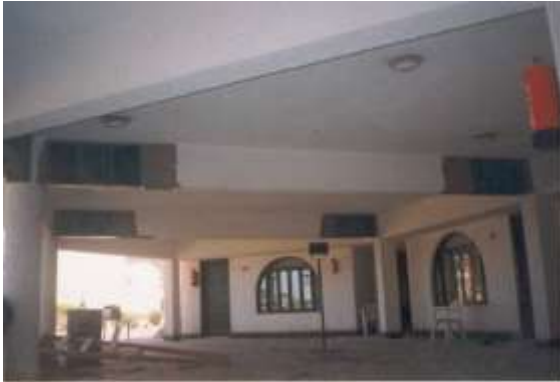
تدعيم الكمرات برقائق المواد البوليمرية المسلحة بألياف الكربون لزيادة مقاومتها للقص
