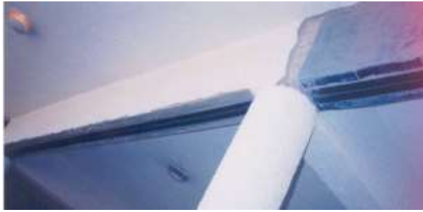
تدعيم الكمرات بألواح المواد البوليمرية المسلحة بألياف الكربون لزيادة مقاومتها لعزوم الإنحناء
