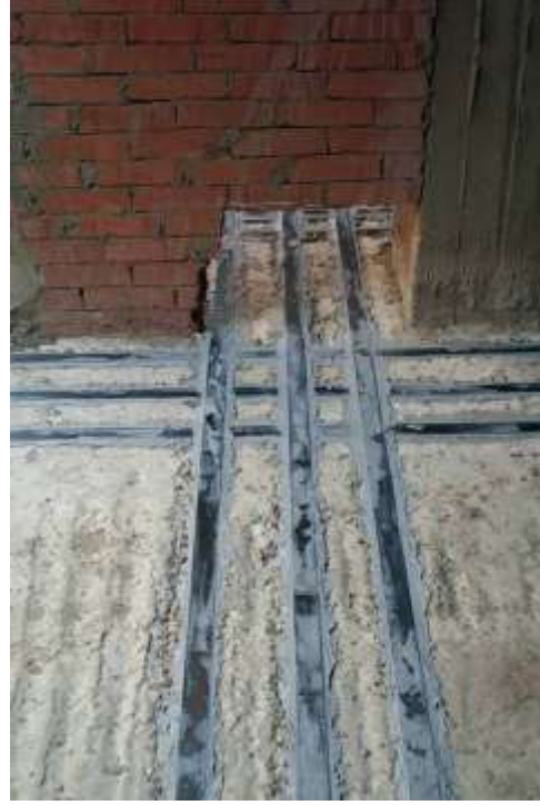
تدعيم السقف بدون الحاجة إلى تكسير الحوائط
