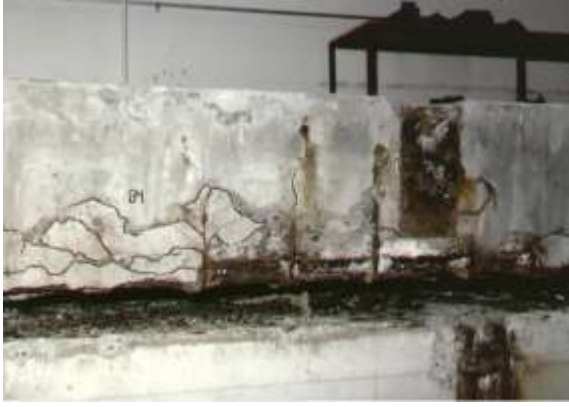
الحالة الراهنة للكمرات: صدأ حديد التسليح - أنهيار الغطاء الخرساني لحديد التسليح - شروخ متنوعة
