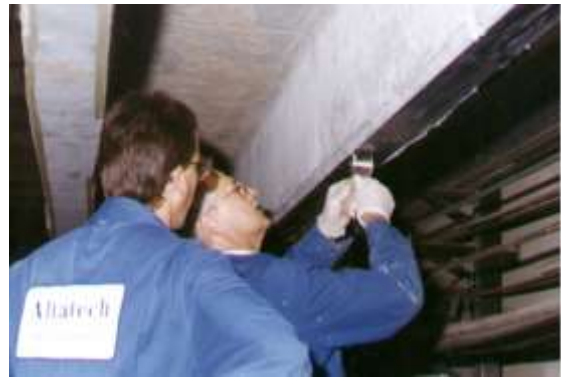
شكل رقم ٦ . خطوات تثبيت ألواح المواد البوليمرية المسلحة بألياف الكربون على الخرسانة
