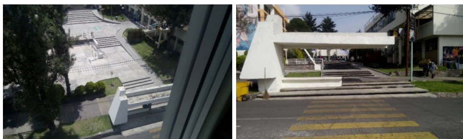
Imagen 8. Incorporación de rampas en la explanada principal por la que se accede al edificio de aulas, talleres y administrativo de la FAD de la UAEMex (Solano, 2018).
