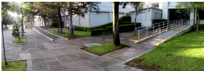
Imagen 3. Adecuación de la infraestructura arquitectónica en el Tecnológico de Monterrey, con la incorporación de rampas con pendientes adecuadas, descansos y pasamanos (Solano, 2018).
