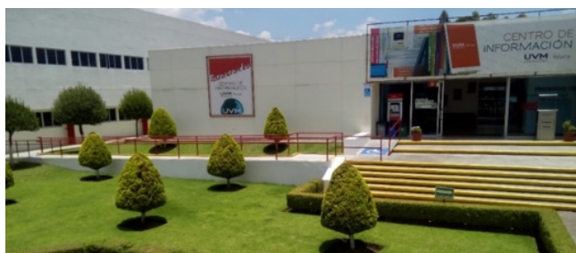
Imagen 5. Incorporación reciente de rampas, y pasamanos en el acceso a la biblioteca de UVM campus Toluca (Solano, 2018).
