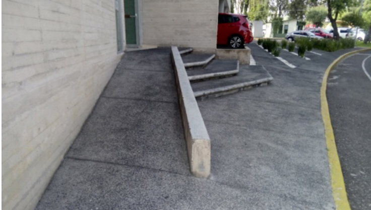
Imagen 10. Rampa de acceso al edificio de posgrado de la FAD cuya pendiente y dimensiones resultan poco apropiadas (Solano, 2018).
