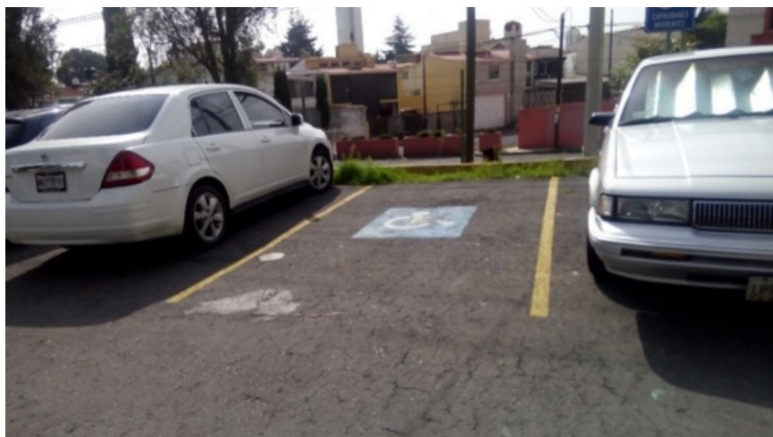
Imagen 9. Cajones de estacionamiento para personas con discapacidad en la FAD que no cumplen con el ancho adecuado (3.80 metros) (Solano, 2018).
