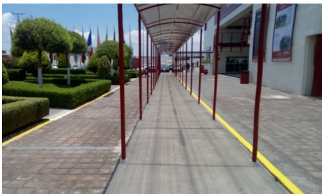
Imagen 7. Cubierta en andadores que anteriormente estaban a la intemperie, intervención reciente (Solano, 2018).
