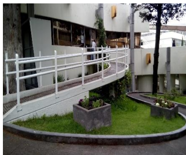
Figura 2. Rampa para acceder al edificio A., 2017
