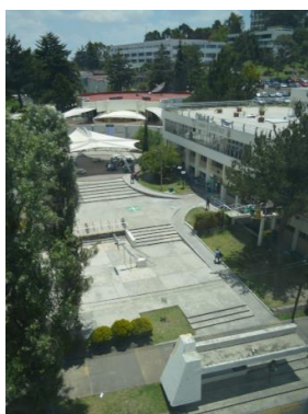
Figuras 6 y 7. Incorporación de rampas en la explanada principal por la que se accede al edificio de aulas, talleres y administrativo de la FAD de la UAEMEX, pero no se salvan los tres primeros escalones. (Fotos: Utrilla y Solano, 2017).
