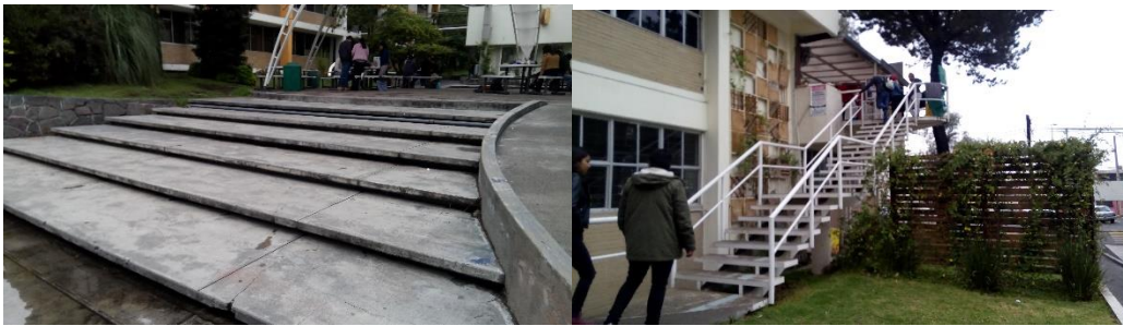
Figura 12 Escalones de huella prolongada con fines estéticos y Figura 13 Escalones que ascienden a la cafetería, con peraltes inconstantes 2017
