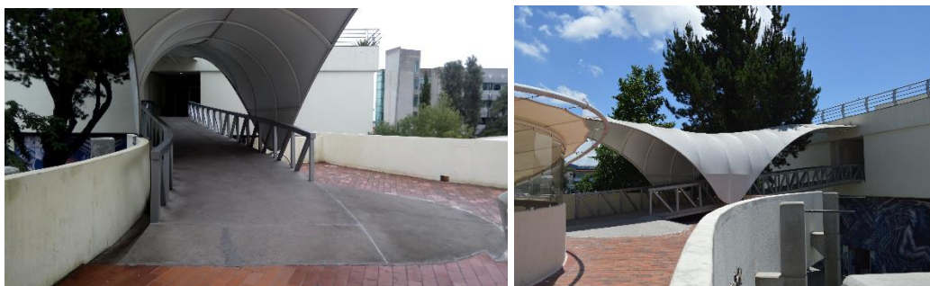
Figura 3. Rampas que conectan edificios A, B y “Bunker., 2017
