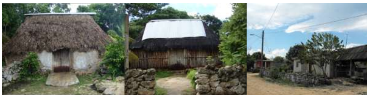
Figura 5. Transformación de la vivienda en los huertos familiares. a) Casa tradicional maya con techo de huano y paredes de lodo seco. b) Casa de un huerto familiar con el techo ya no de huano, sino de cartón y c) Casa con construcciones y detalles de mampostería.
