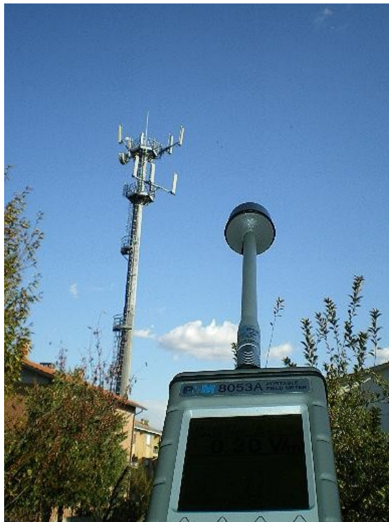
Misura di campo elettrico in prossimità di una stazione radiobase
