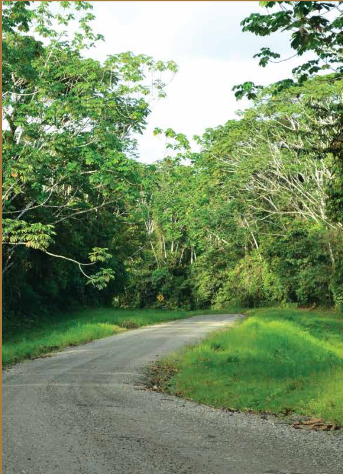
Carretera Pompeya Sur-Iro-Ginta, cerca del puente sobre el río Yasuní, Bloque 16.
