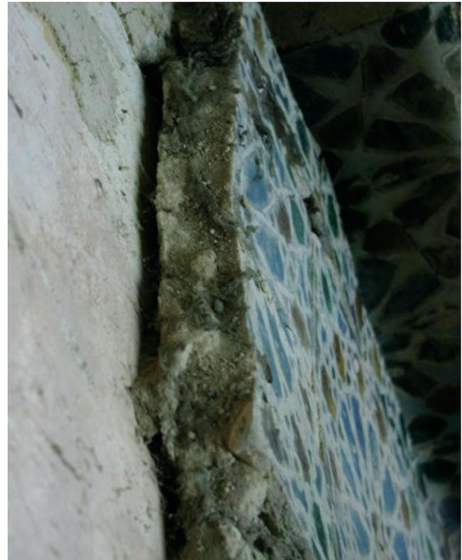
Fig. 14 | Pormenor do destacamento em bloco entre a argamassa de assentamento e o suporte estrutural
