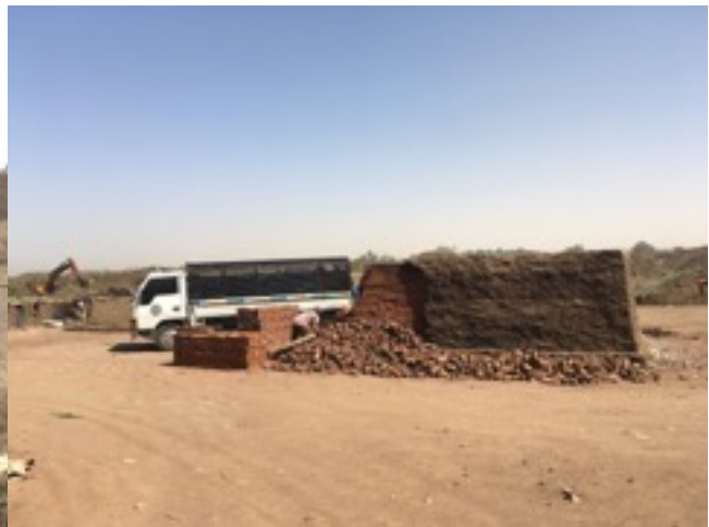
Figure 17 : Du four au camion. © CPH. Al Gereif Gharb, 10/2/2020
