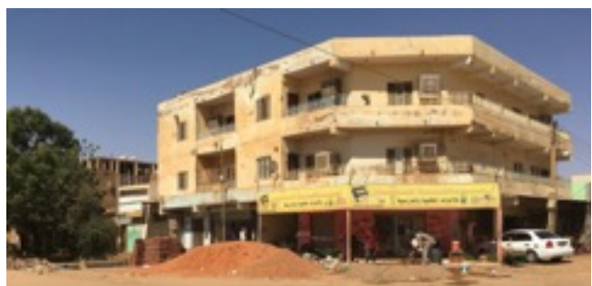
Figure 25 : Briques, sable et granulat devant un chantier. © CPH, 3/2/20, Khartoum 2
