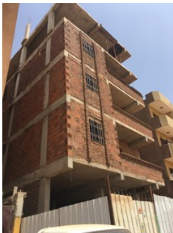
Figure 45 : Immeuble de plus de trois étages en chantier, principalement construit en brique ḥarārī . © CPH, 14/3/20, rue 41.
