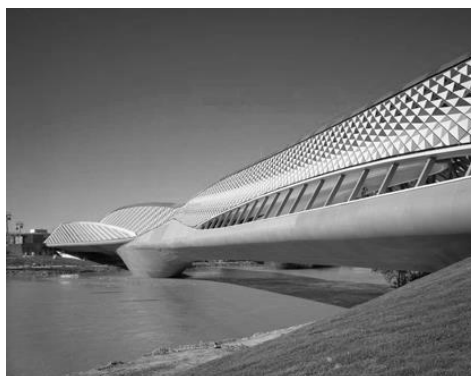
Figura 2.42. Ponte em Zaragoza (Espanha), feita de betão reforçado com fibras de vidro e cobertura com carbono/epoxy.
