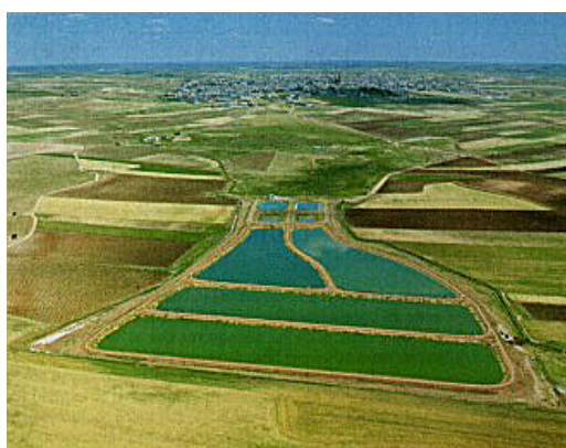
Figura 13.1. Sistema típico de lagunas
