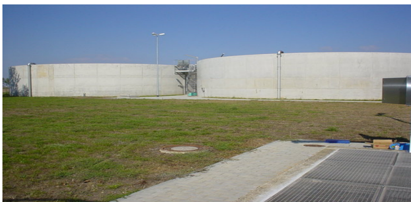
Figura 12.5 Reactores anaerobios convencionales para la digestión de lodos
