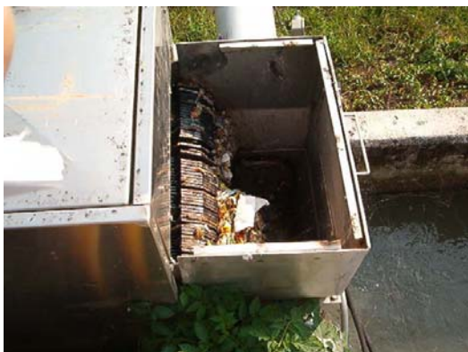
Figura 4.2. . Vista de dos modelos diferentes de cámaras de rejas de limpieza automática
