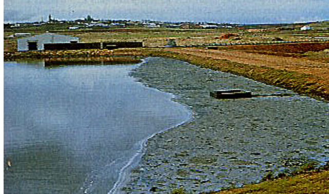
Figura 13.5. Laguna anaerobia con superficie parcialmente cubierta
