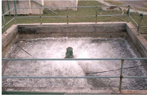
Figura 8.1. Tanque compensador con agitación superficial
