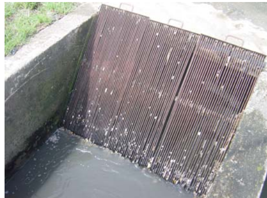
Figura 4.1.. Rejas de limpieza manual. Izquierda, rejas gruesas. Derecha, rejas finas.
