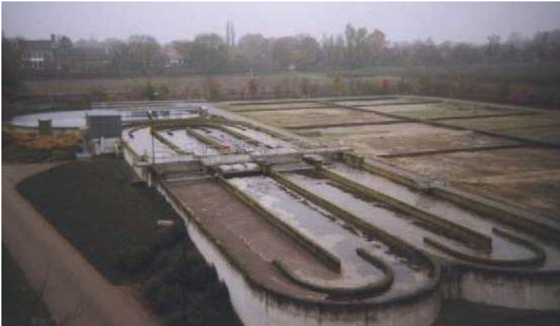
Figura 10.9. Canal de oxidación con sedimentación secundaria
