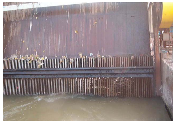
Figura 4.2. . Vista de dos modelos diferentes de cámaras de rejas de limpieza automática
