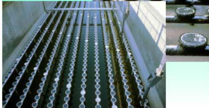
Figura 10.14. Distribución de los difusores. Vista de planta
