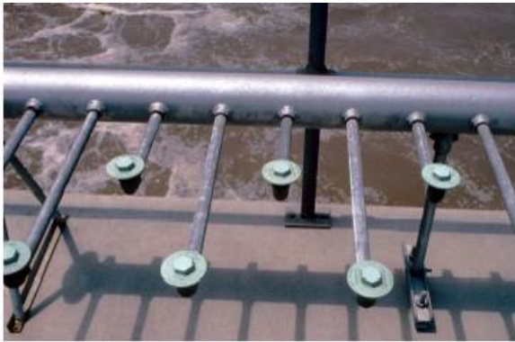
Figura 10.13. Implementos para la aireación mediante aire difundido
