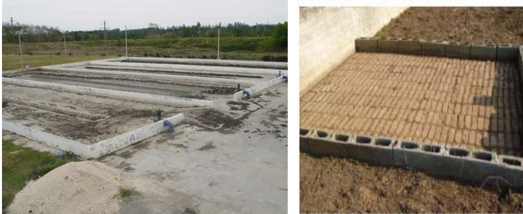
Figura 12.10. Lechos de secado típicos. A la derecha detalles del piso del lecho
