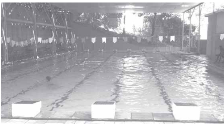
Figura 7. Piscina. Fonte: própria.
