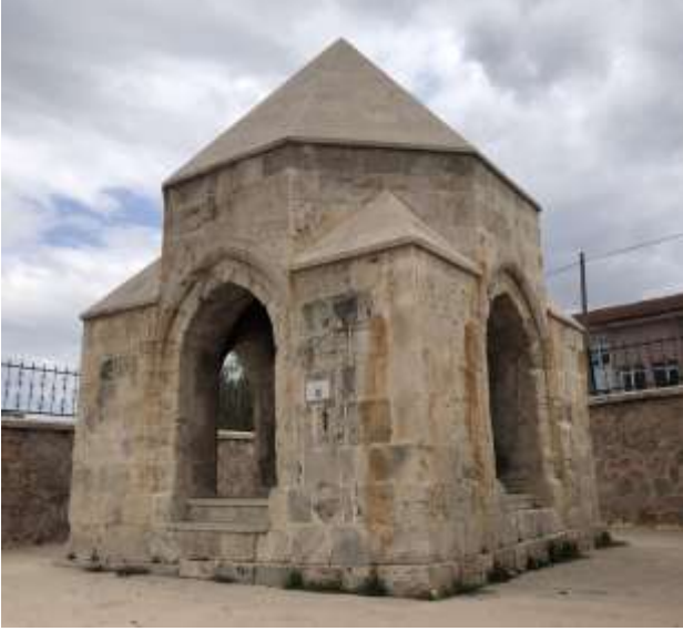
Görsel 10. Erenler Türbesi, restorasyon sonrası güncel durumu
