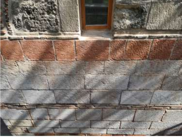
Görsel 4. Burgaç Hatun Türbesi, gövdede kullanılan kesme taş ve tuğla sırası
