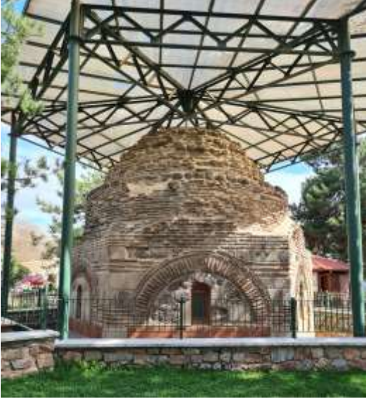
Görsel 5. Burgaç Hatun Türbesi, cephe
