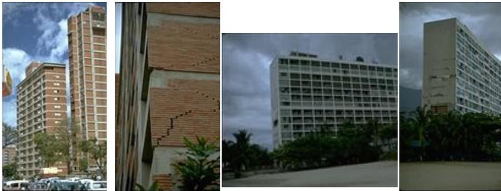
a) Edificios Petunia, con una línea de defensa (muros) en la dirección corta, esbeltos y planta alargada
