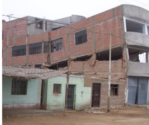
b) Colapso de edificio poco redundante en la dirección esbelta durante el sismo de Pisco. Foto cortesía de Javier Piqué
