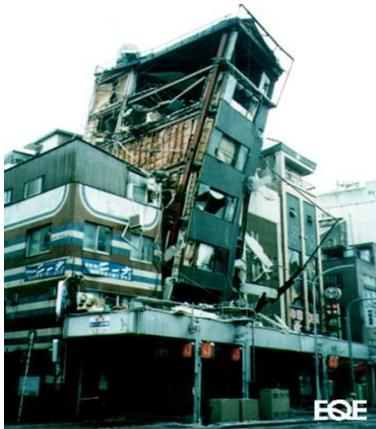
a) Colapso de edificio poco redundante en la dirección esbelta durante el sismo de Kobe. (<http://www.eqe.com/publications/kobe/kobe.htm>)
