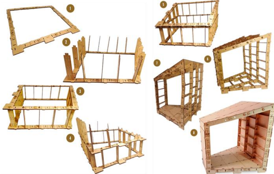
Figura 6. Processo de montagem do protótipo em escala reduzida.
