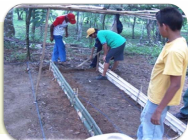
FIGURA 12. Construcción de un semillero con tallos de bambú y caminerías.
