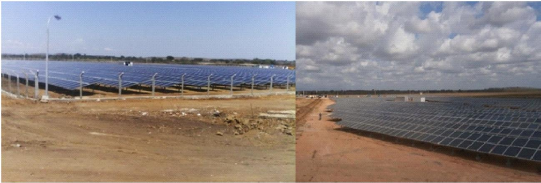
Figura 2.3 Ejemplo de parques fotovoltaicos construidos en Cuba.
