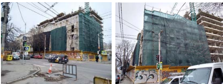
Fig.3.5. Starea curentă, februarie 2020, pe locul monumentului de arhitectură de însemnătate națională, str.București, 62
