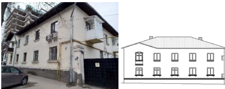
Fig.3.15. Monument de arhitectură de însemnătate locală, str. Vlaicu Pîrcălab, 41 (ferestre-termopane albe și cafenii; balcoane remodelate)
