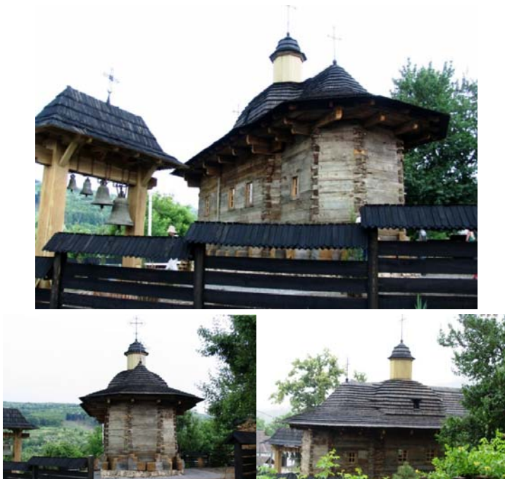
Fig.3.39. Biserica „Acoperământul Maicii Domnului” din satul Palanca, r-nul Călărași, 1847
