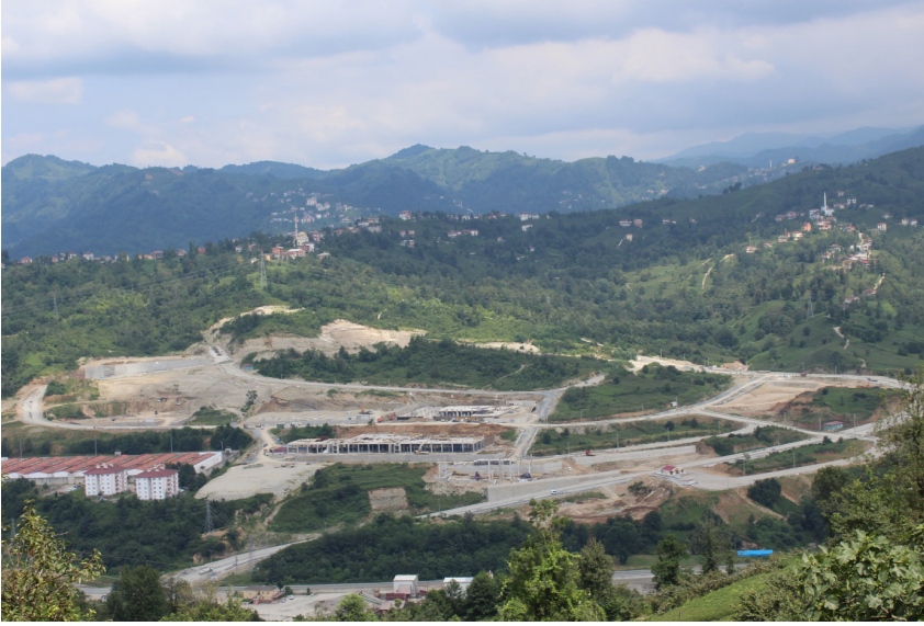
Fotoğraf 5.1. Kalkandere ilçesi, Rize-Erzurum karayolu kenarında, altyapı inşaatı 2016 sonunda tamamlanması planlan Rize OSB.
