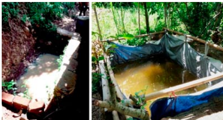
Gambar 6.12 Tempat Penampungan Air Hujan Berupa Galian Tanah (Kiri); dan yang Dialasi Terpal (Kanan) di Dusun Apit Aik, Kecamatan Batu Layar Timur, Labupaten Lombok Barat
