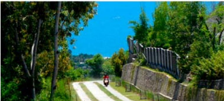
Gambar 6.20 Jalan Menuju Dusun Duduk Atas yang Masih Asli (Atas); yang Sedang dalam Pengerjaan (Tengah); dan yang Sudah Selesai Pengerasan dan Pengecoran
