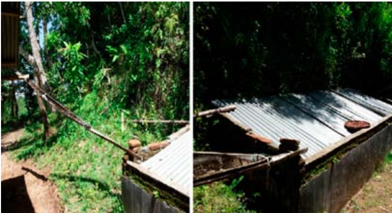
Gambar 6.13 Tempat Penampungan Air Hujan Permanen di Dusun Apit Aik (Kanan), yang dialirkan dari Talang (Kiri), Kecamatan Batu Layar Timur, Labupaten Lombok Barat
