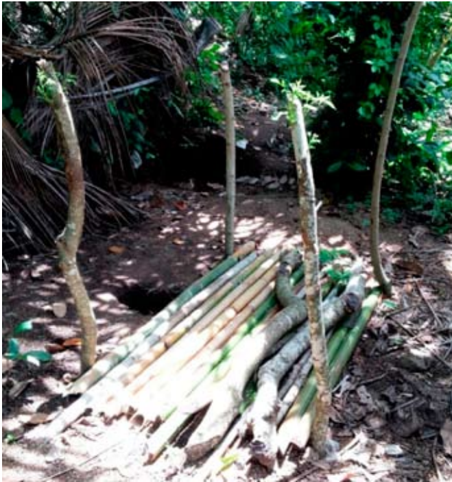
Gambar 6.14 WC Cemplung di Dusun Apit Aik, Kecamatan Batu Layar Timur, Kabupaten Lombok Barat
