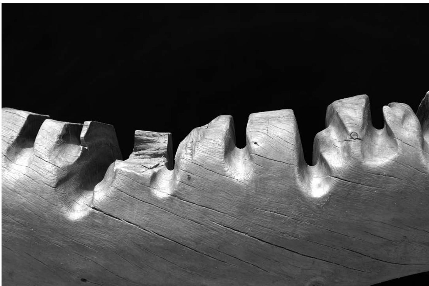
Usure des bois de puits par les cordes - Niger, 1981
