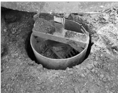
Atelier Calweld utilisé pour le fonçage de puits à moyenne profondeur en terrain meuble. Munie d'une kelly télescopique cette machine peut forer et équiper en une journée, un puits de un mètre de diamètre, à une vingtaine de mètres de profondeur - Côte d'Ivoire, 1973.
