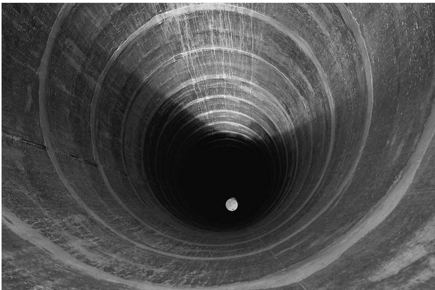
Cuvelage monolithique sur un puits profond - Région de Maradi - Niger
