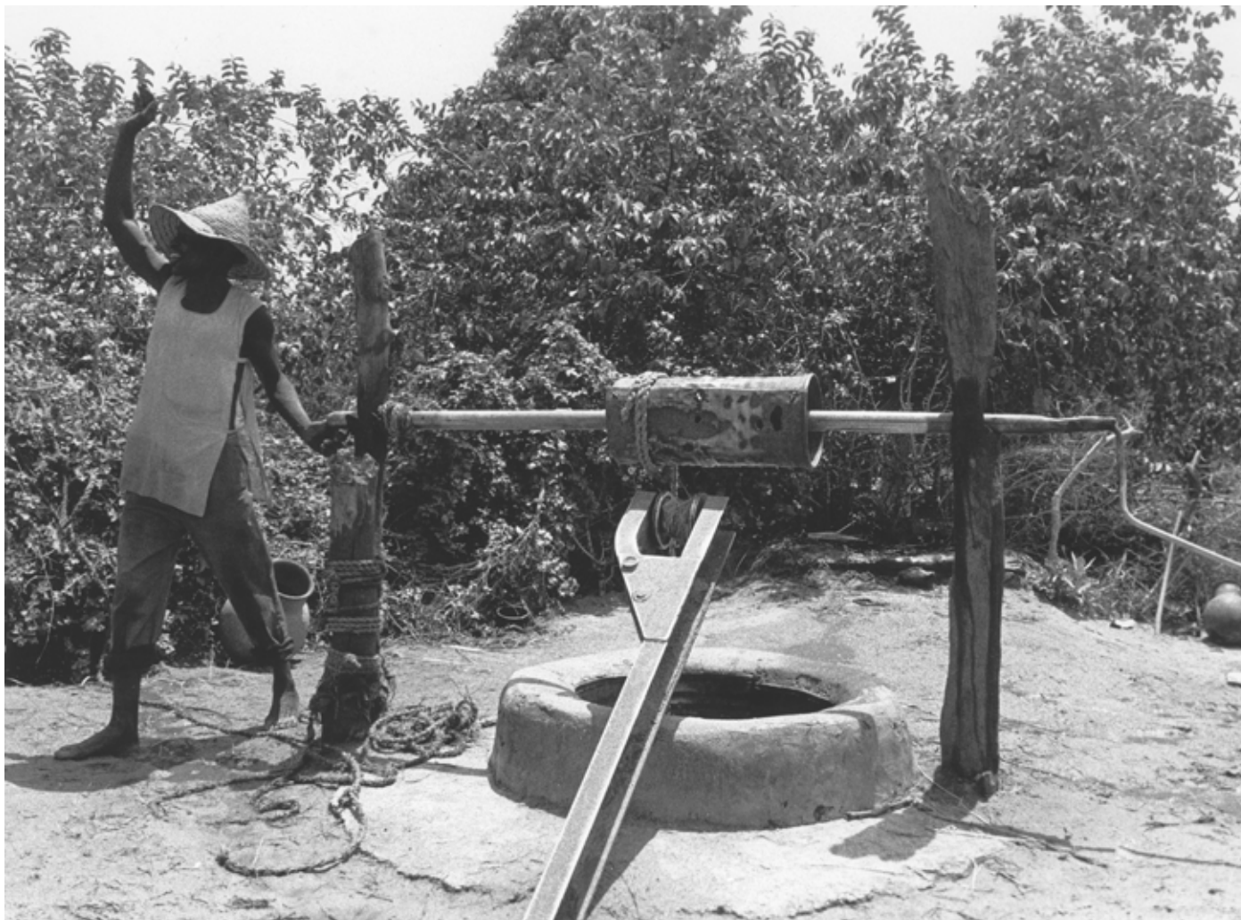
Amélioration de l'exhaure - Treuil et poulie sur un puits traditionnel - Tchad, 1976
