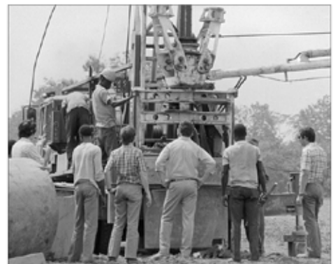
Atelier Calweld utilisé pour le fonçage de puits à moyenne profondeur en terrain meuble. Munie d'une kelly télescopique cette machine peut forer et équiper en une journée, un puits de un mètre de diamètre, à une vingtaine de mètres de profondeur - Côte d'Ivoire, 1973.
