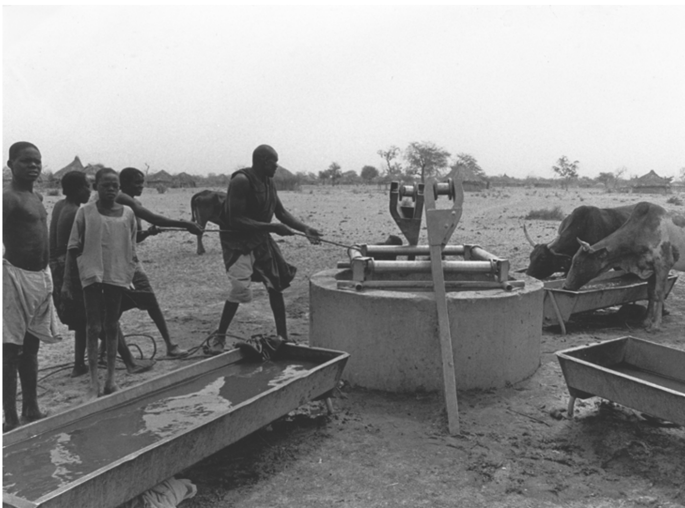
Amélioration de l'exhaure traditionnelle - Poulies et rouleaux métalliques - Tchad, 1976
