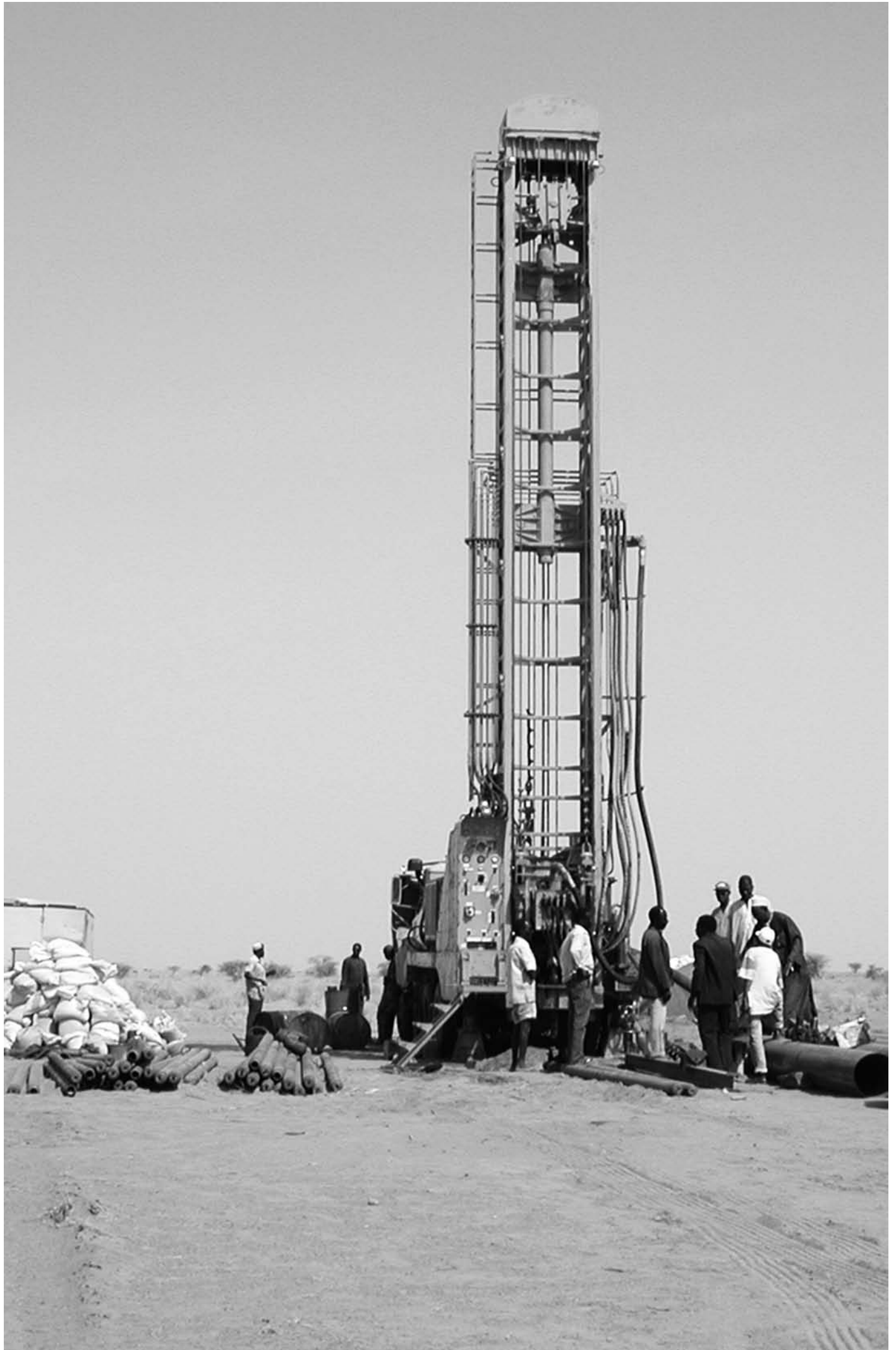
Atelier de forage grande profondeur au Niger
