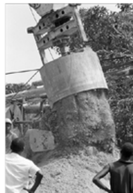
Atelier Calweld utilisé pour le fonçage de puits à moyenne profondeur en terrain meuble. Munie d'une kelly télescopique cette machine peut forer et équiper en une journée, un puits de un mètre de diamètre, à une vingtaine de mètres de profondeur - Côte d'Ivoire, 1973.
