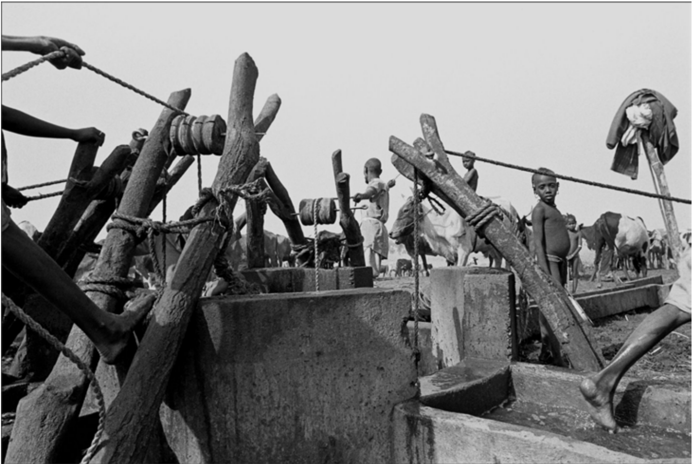
El Kelani - Puits traditionnel avec exhaure par traction animale à 60 m de profondeur - Tchad, 1976
