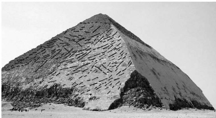
1. attēls. Lauztās piramīdas rietumu fasādē noteiktās plaisas.
